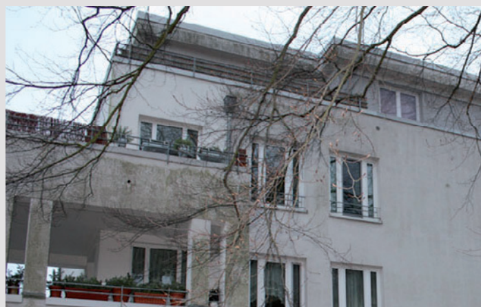
Testoppervlak met KefaTherm -gevelpleister op isolatie.
