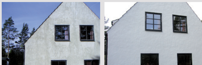
Gebouw voor de sanering
