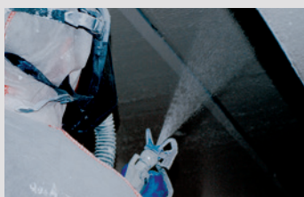
Verwerking met airless toestel
