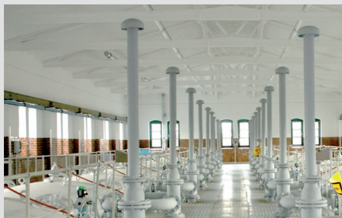
Mit KefaTherm behandelte Bollmannfilteranlage eines Wasserwerkes.
